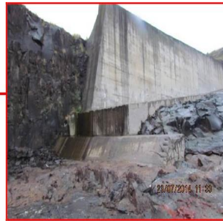
Ilustración 17 Detalle de los daños en la base del muro
