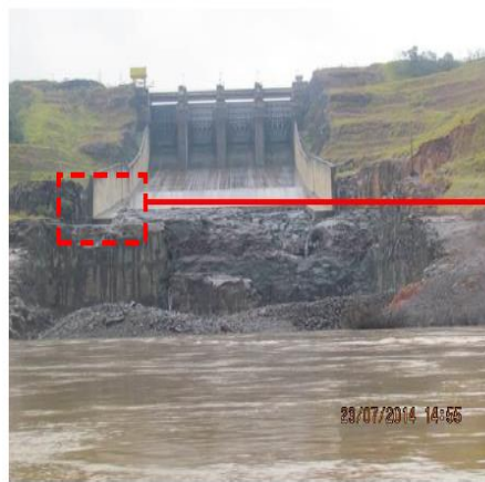
Ilustración 17 Detalle de los daños en la base del muro
