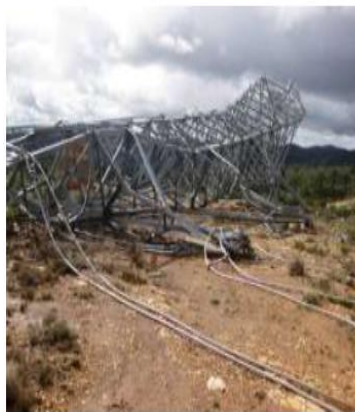
A la izquierda el primer apoyo caído de la línea 1 y a la derecha vista general de otros dos y la cruceta de otro en la misma línea.
