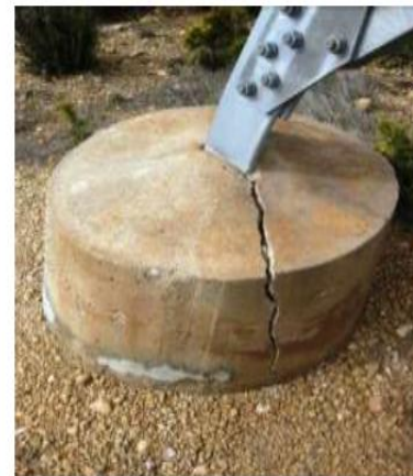
A la izquierda vista general de las bases hormigonadas de las torres y a la derecha una de las bases afectadas.
